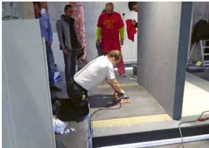
Práce s vibračním zhutňovačem
